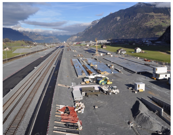
Installationsplatz Nord im Januar 2011.
