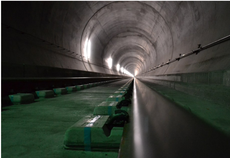
Einbau der Festen Fahrbahn im Abschnitt Faido-Bodio West.
