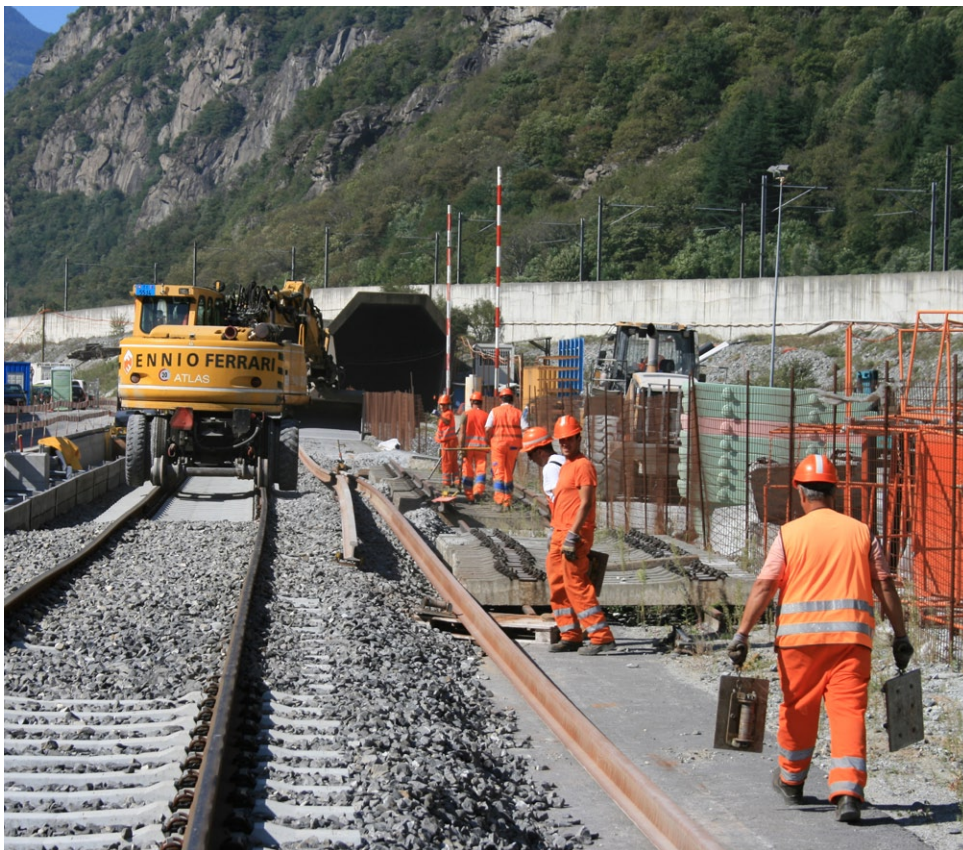
Aufbau der Schotterstrecke Portal Bodio.
