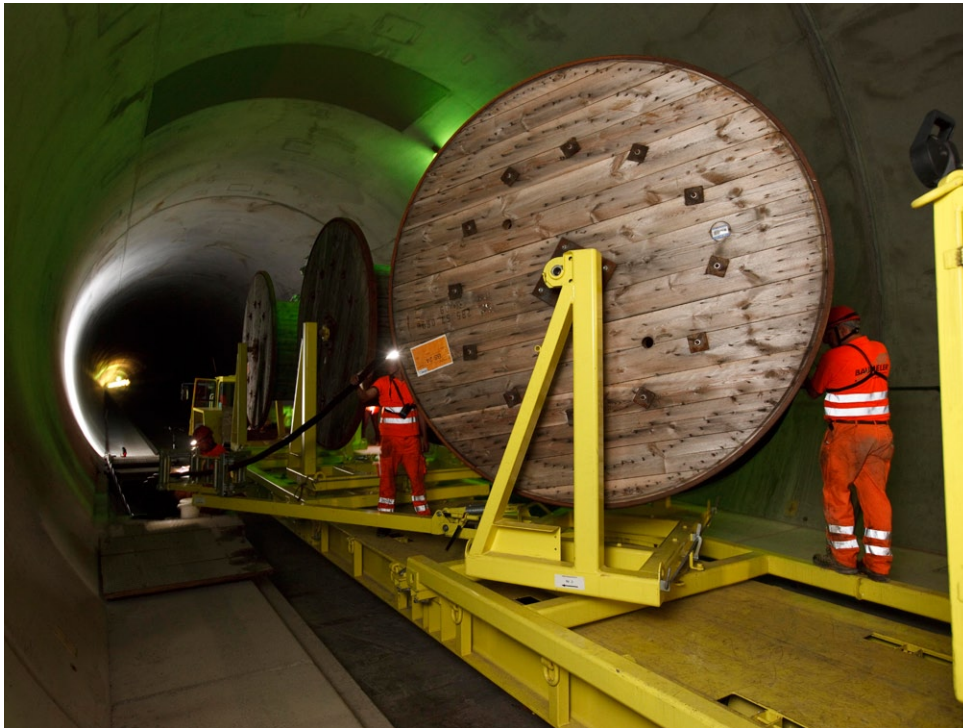
Kabeleinzugsarbeiten mit dem Multifunktionsfahrzeug.
