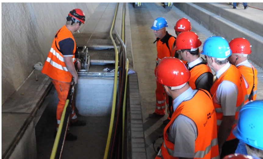
Zuschauer beim Kabeleinzug Faido-Bodio West.
