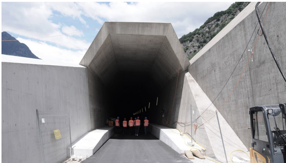
Tunnelportal Faido-Bodio West, Mai 2010.
