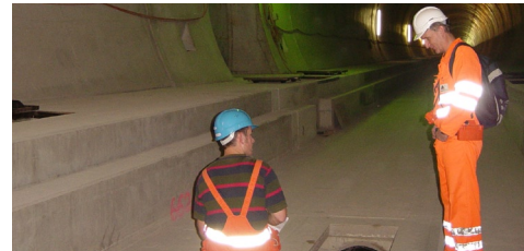
Prüfung der Entwässerung im Tunnel
