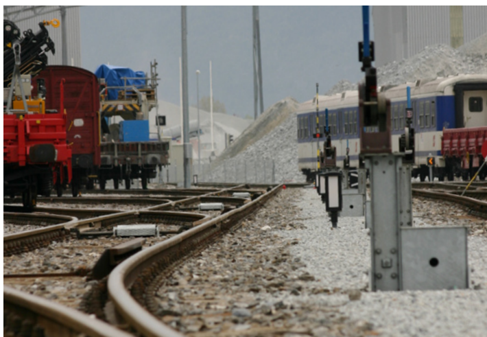
Gleisanschluss eines Installationsplatzes wie er auch in Biasca aussehen könnte.
