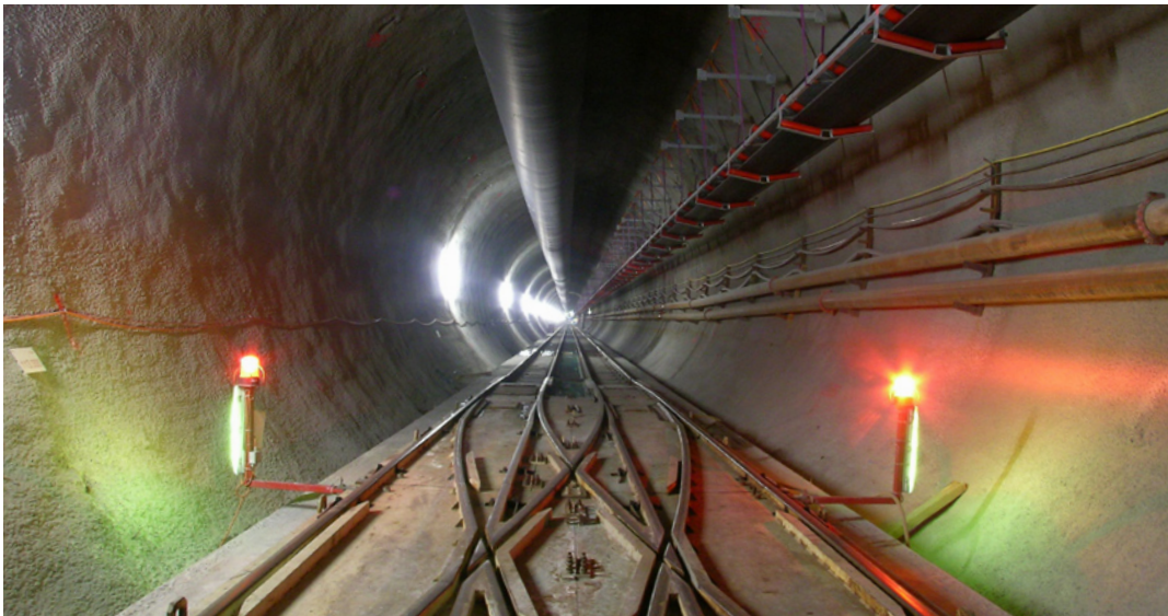
Einspurtunnel Ost. © AlpTransit Gotthard AG
