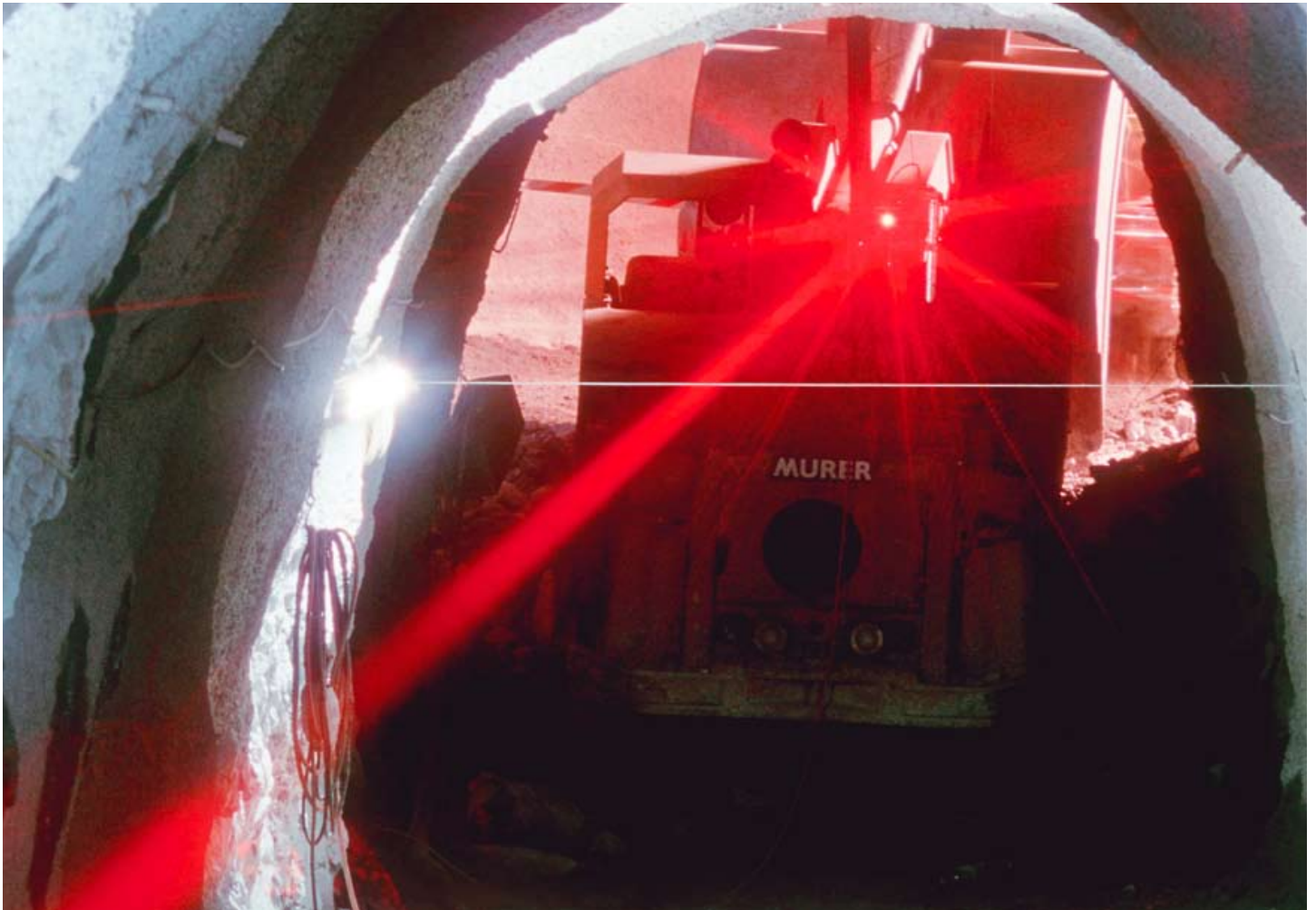
Einspurtunnel Ost (Copyright: AlpTransit Gotthard AG)
