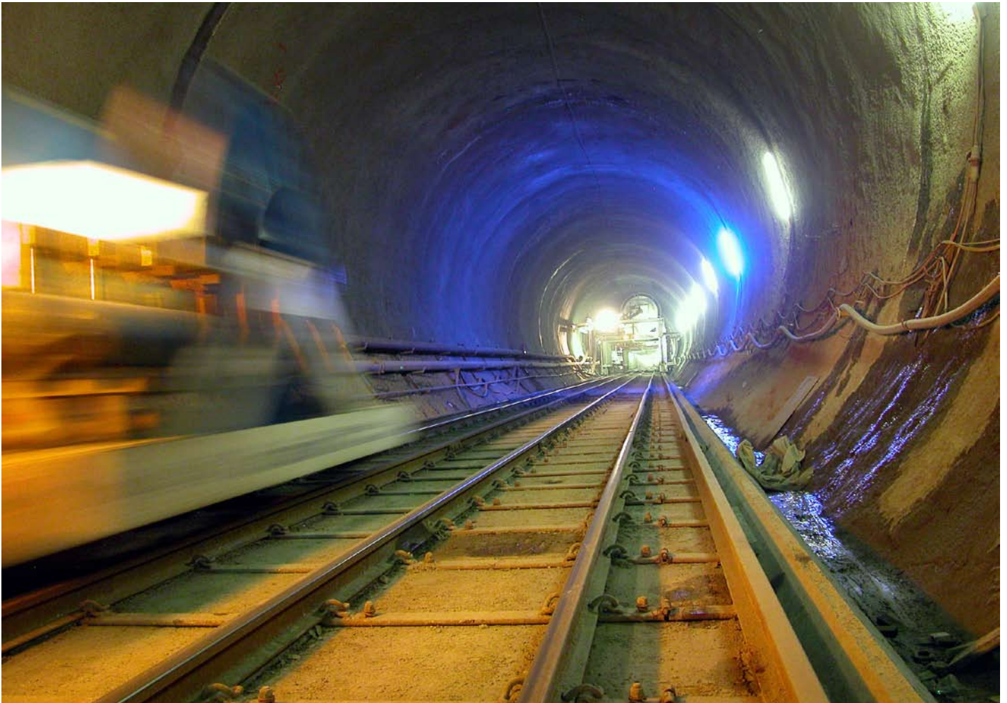
Einspurtunnel Ost (Copyright: AlpTransit Gotthard AG)
