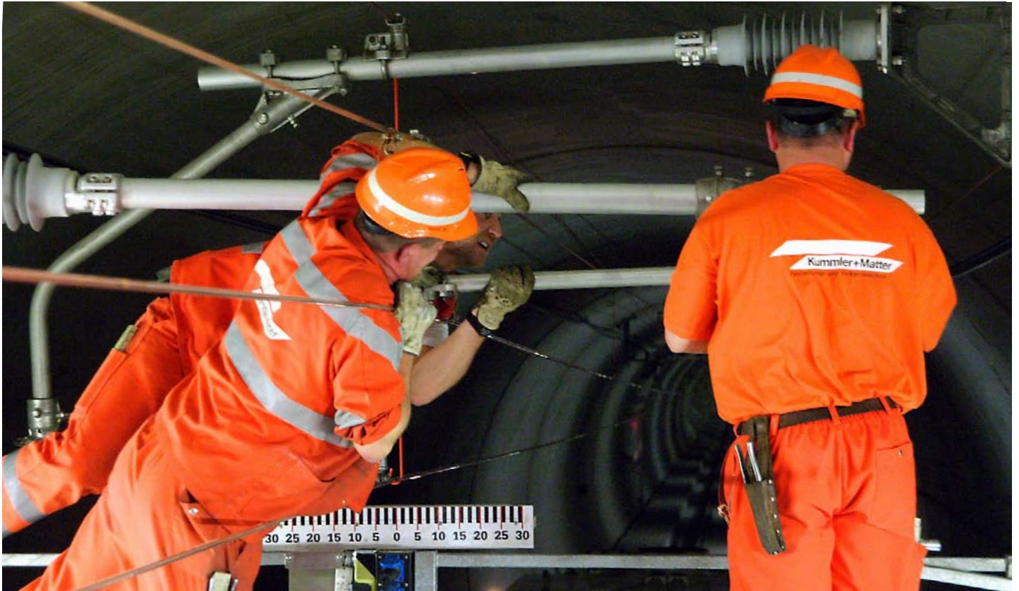
Monteure der Kummler+Matter bei Arbeiten an der Fahrleitung im Lötschberg-Basistunnel
