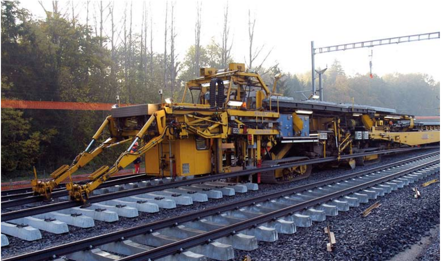
Gleisbaumaschine PUMA 90, von Scheuchzer entwickelt für den Neubau und die Erneuerung von Gleisen.
