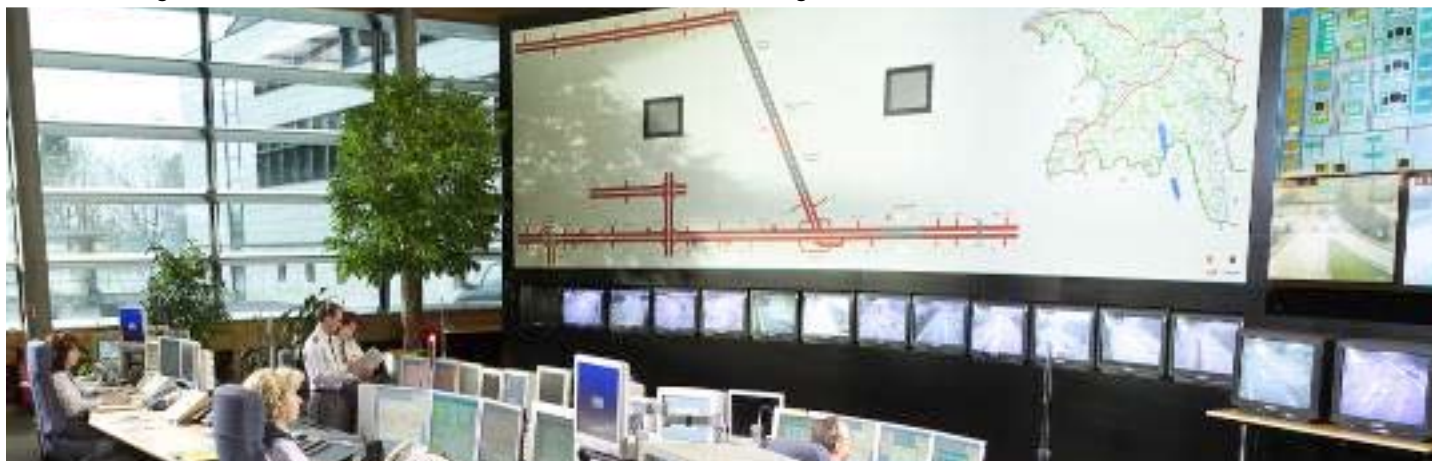
Verkehrsleitzentrale der Kantonspolizei Aargau Lenzhard von ABB.
