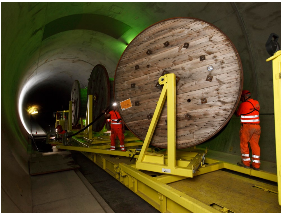
Kabeleinzugsarbeiten mit dem Multifunktionsfahrzeug.
