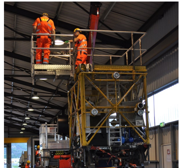
IP Biasca: Vorbereitungen zum Einbau der Fahrleitung.
